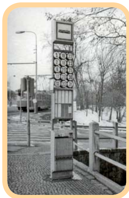
Potřeba vyznačení vyššího počtu projíždějících linek vedla k tomu, že některé sloupky byly ověšeny celou řadou smaltovaných čoček s jejich čísly. Důvodem zdvojeného označení některých linek je odlišná trasa v nočním provozu. Denní linky byly provedeny modře, noční pak červeně. Pražský hrad, 21. března 1976.
