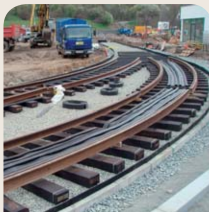
Pokládka kolejí ve smyčce v prostoru před budovou sociálního vybavení
