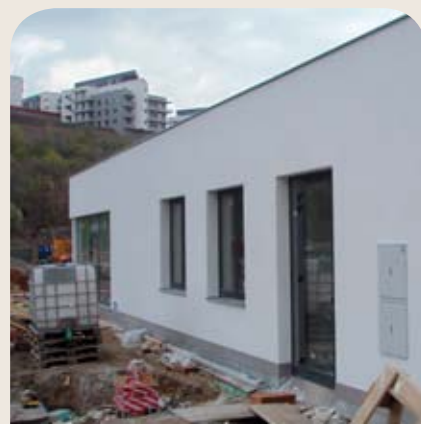
Budova sociálního zařízení řidičů tramvají na budoucí smyčce
