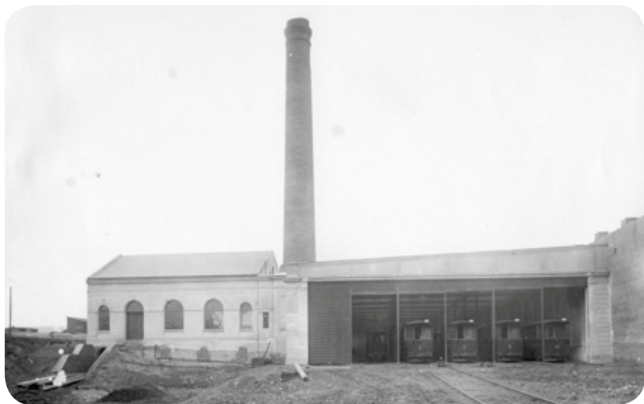
Vozovna a elektrárna Elektrické dráhy Praha – Libeň – Vysočany v březnu 1896.
