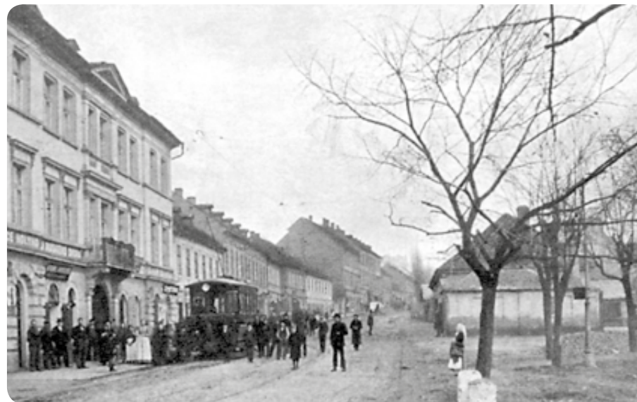
Tramvajová stanice U Ruského dvora ve Vysočanech. Domy na snímku už neexistují. Snímek byl pořízen jen pár desítek metrů pod dnešní zastávkou Nádraží Vysočany.
